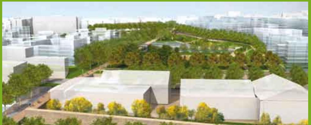
Vue sur le parc depuis les logements au nord
