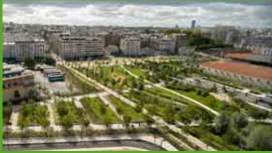
1 ère tranche du Parc Clichy-Batignolles-Martin Luther King (2007)
